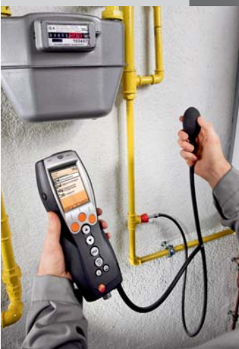
Проверка герметичности газовой трубы
